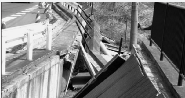
茨城県東茨城郡茨城町国道6号線
