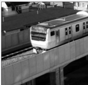
写真提供：日本コンクリート工業株式会社
