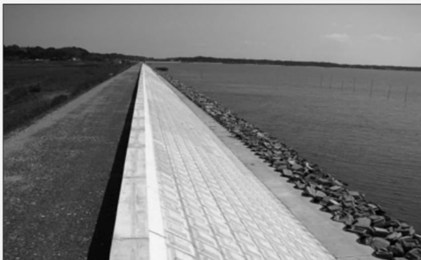
茨城県水戸市の南10kmにある涸沼では、堤防延長16km・面積66,000平米の護岸が被災し、これらに対する20件の災害復旧工事が発注されました。当社では、防災型張ブロックを3工区に対し8,300平米、大型張ブロックは同じく3工区7,200平米、波返ブロックは4工区に対し2kmの製品を納入いたしました。
