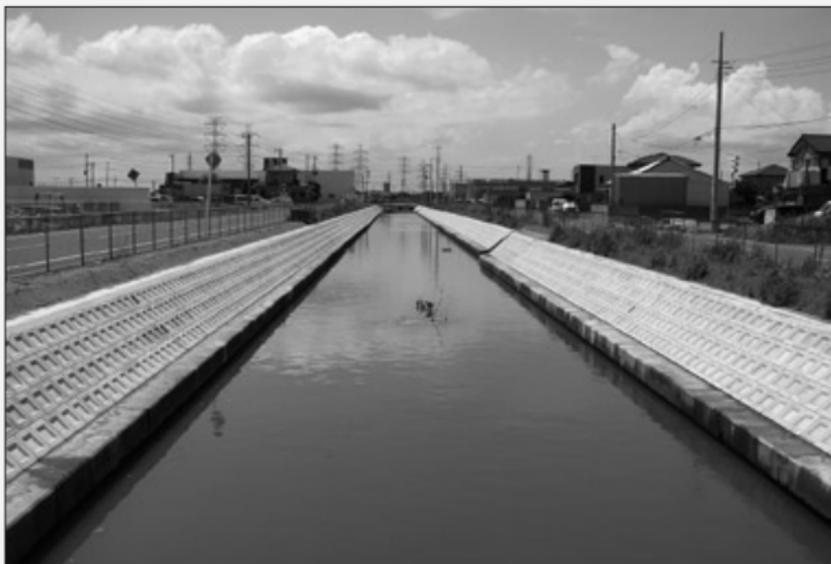
堀割川は、国道124号線を横断しており、河川堤防が地震の揺れによる原因で法面が崩壊しました。この河川の災害復旧工事に使用された張ブロックは、以前茨城県農地部で採用されていた40cm四方の真四角のブロックで、涸沼や霞ヶ浦型に採用されている50cm四方のブロックとは異なり、これまでに2工区の工事が完了し、現在1工区の工事が進められております。
