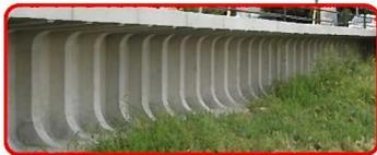
④軽量化と高強度を実現したリブ構造
